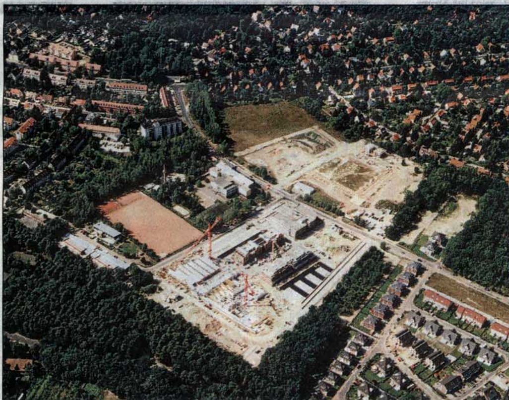
Die Baustelle „Ortszentrum Kleinmachnow“ von oben: Bis Mitte 2004 soll der Großteil vollendet sein. Marktplatz, Läden und Rathaus stehen den Einwohnern dann zur Verfügung. FOTO: L. HANNEMANN
